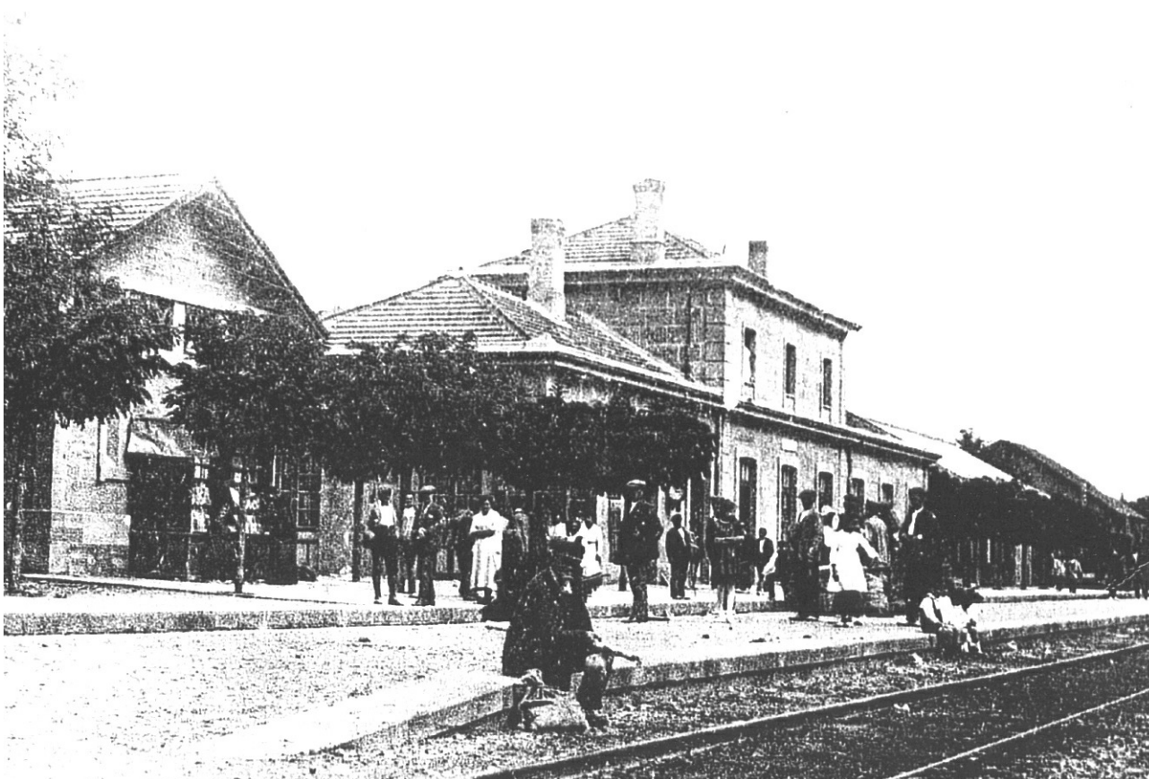
Estación de ferrocarril de Sabiánigo (1950-1954)
