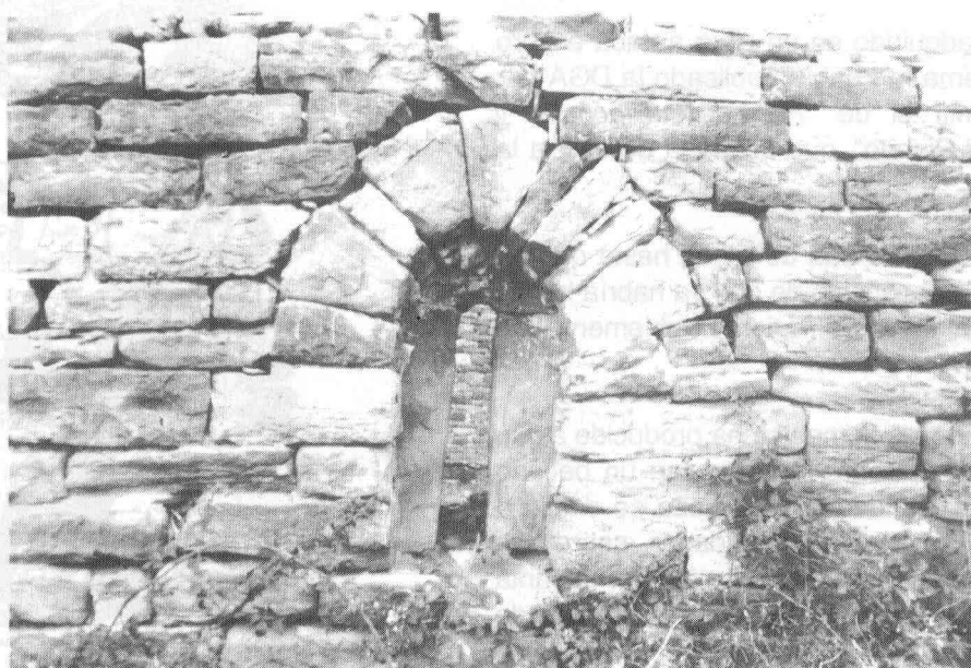
San Julián de Asprilla. Exterior del vano absidal.
